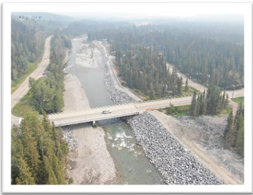
East Barrier: Balsam Bridge
