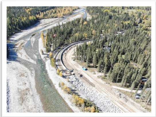
West Barrier: Bracken Road
